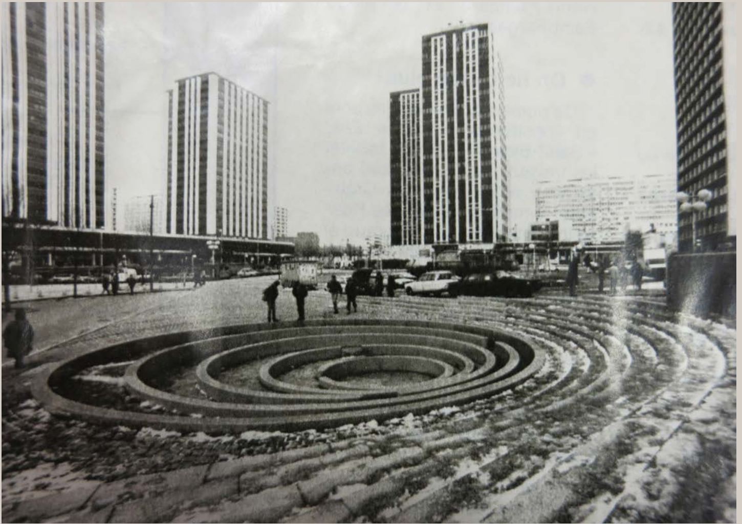
Fig. 23 - Chantier de la fontaine de Marta Pan.
