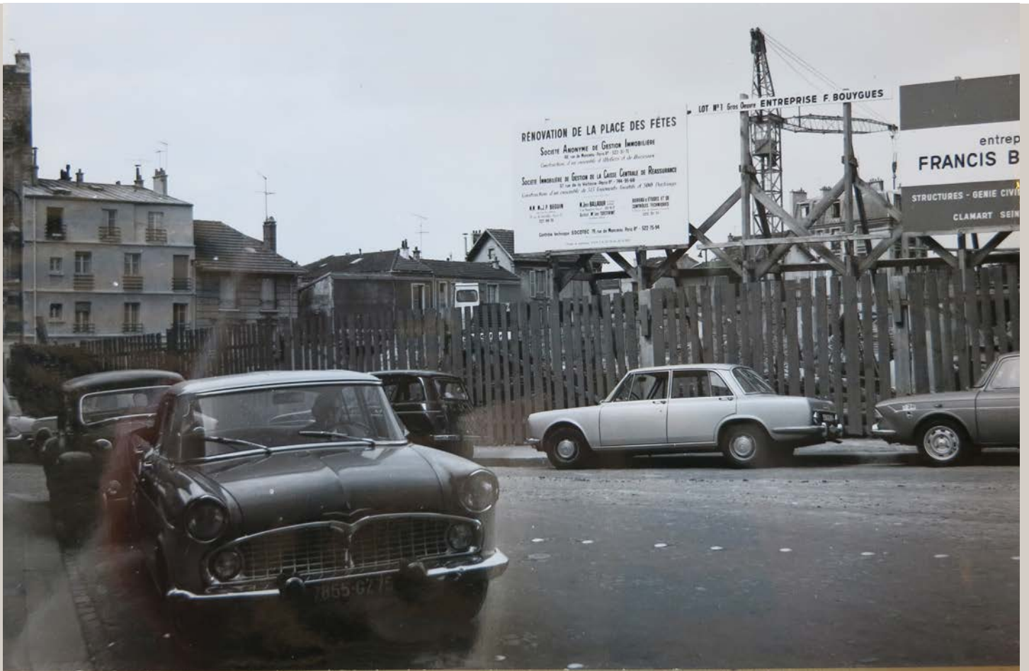
Fig. 19 - La place lors de son aménagement vers 1972. Un permis de 1973 autorisa la construction de 487 places de stationnement enterrés, sur trois niveaux.
