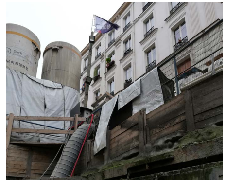
Ce tuyau et le matériel sous les bâches, c'est l'extracteur d'air, grand responsable du bruit généré en journée.
