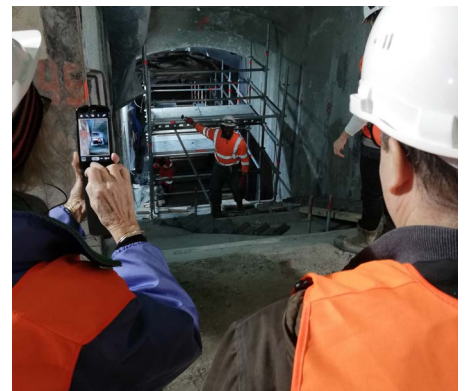
L'accès au chantier souterrain se fait par un puits de près de 20 mètres de profondeur.
