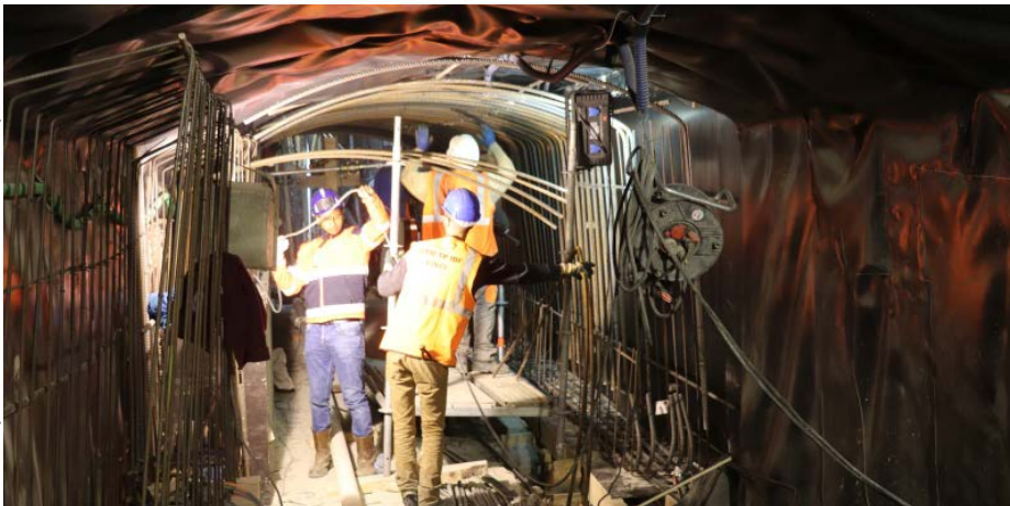
Ce tuyau et le matériel sous les bâches, c'est l'extracteur d'air, grand responsable du bruit généré en journée.
