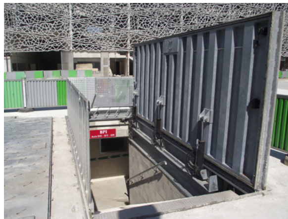
Issue de secours sous forme de trappe
