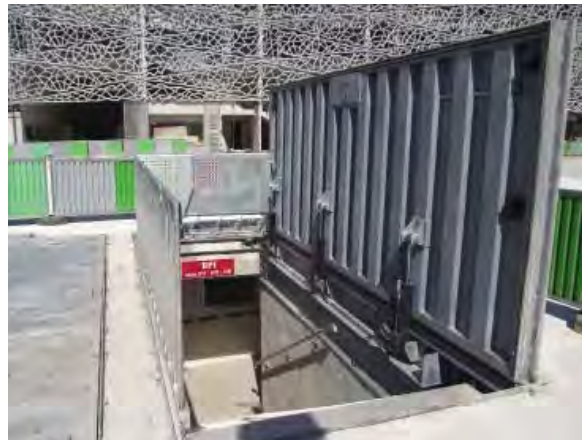
Issue de secours sous forme de trappe
